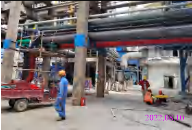
拟改造装置区现状
