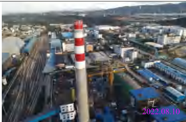
综合楼区域无人机俯瞰图
