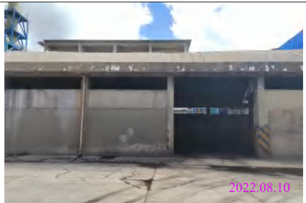
拟改造装置区现状
