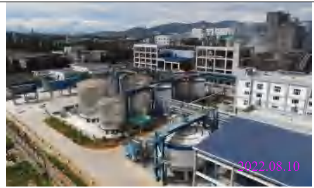
磷酸、硫酸罐区无人机俯瞰图
